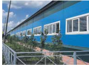
Новые производственные помещения предприятия на ул. Комитетская, 2020-е гг.
